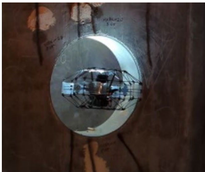
Рис. 6. – Инспекция железобетонных конструкций в ходе строительства
