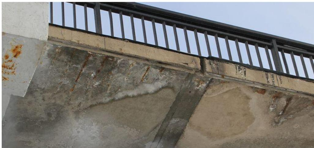
Рис. 1. – Коррозия бетона несущей конструкции (пролетное строение)
