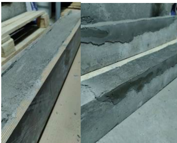
Рис. 10. – Балки с восстановленным защитным слоем бетона
