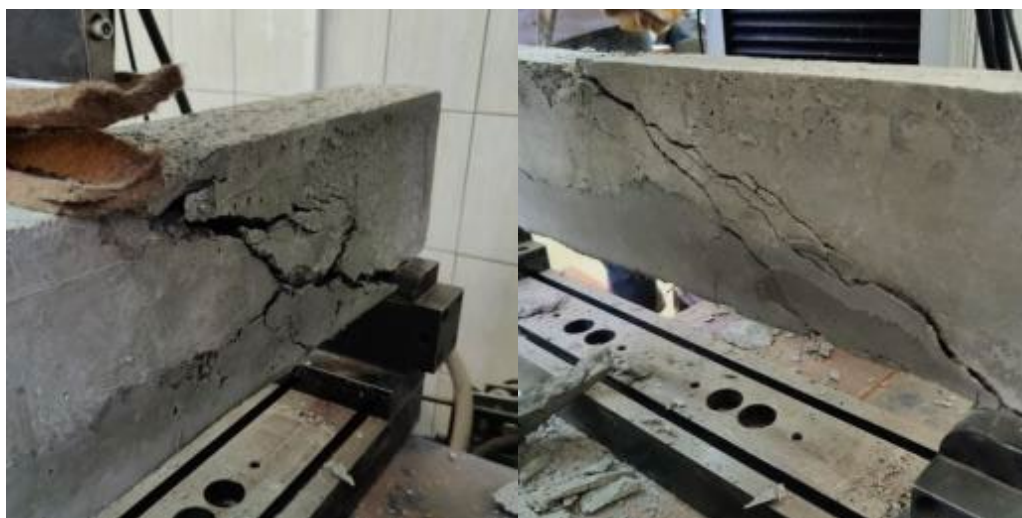
Рис. 12. – Разрушение балок с восстановленным защитным слоем
