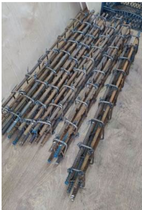
Рис. 7. Арматурные каркасы
