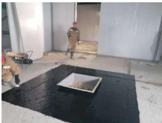
Рис.3. – Жидкая гидроизоляционная мембрана.
