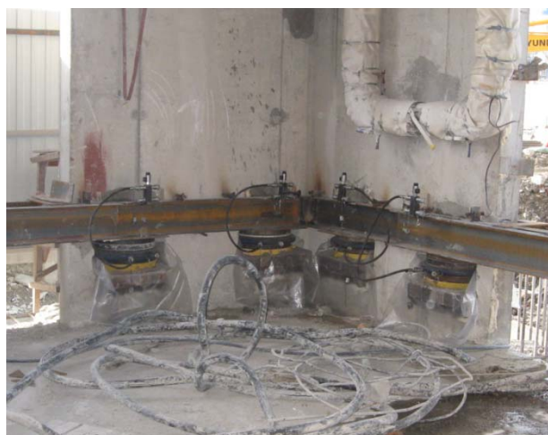
Рис. 5 Конструкции регулируемого фундамента 10-ти этажного здания.
