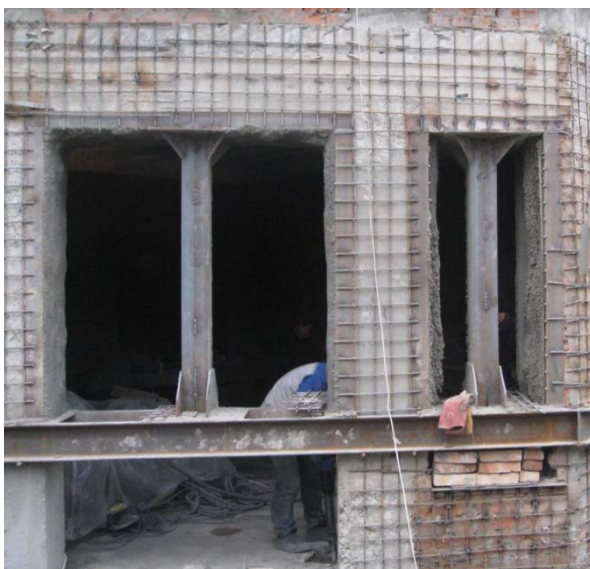
Рис. 4 Конструкции регулируемого фундамента 5-ти этажного здания.
