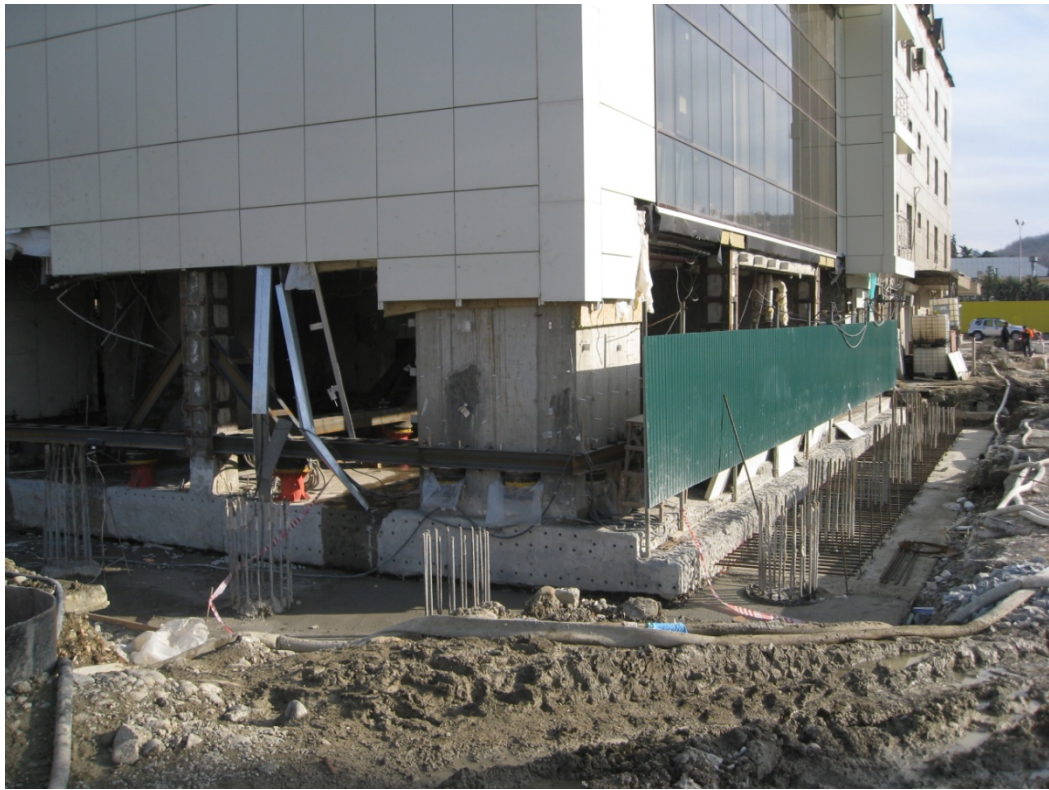
Рис. 3 Устройство свайного ростверка усиления фундаментной плиты
