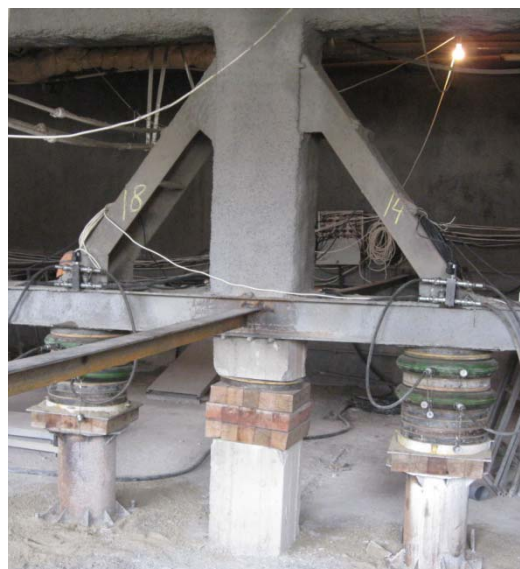
Рис. 4 Конструкции регулируемого фундамента 5-ти этажного здания.
