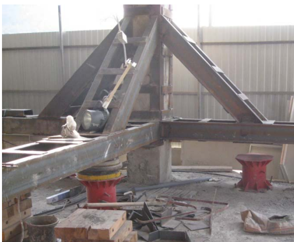
Рис. 5 Конструкции регулируемого фундамента 10-ти этажного здания.
