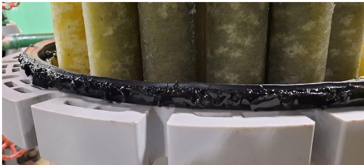
Рис. 8 – резиновая прокладка между обечайками корпуса фильтра
