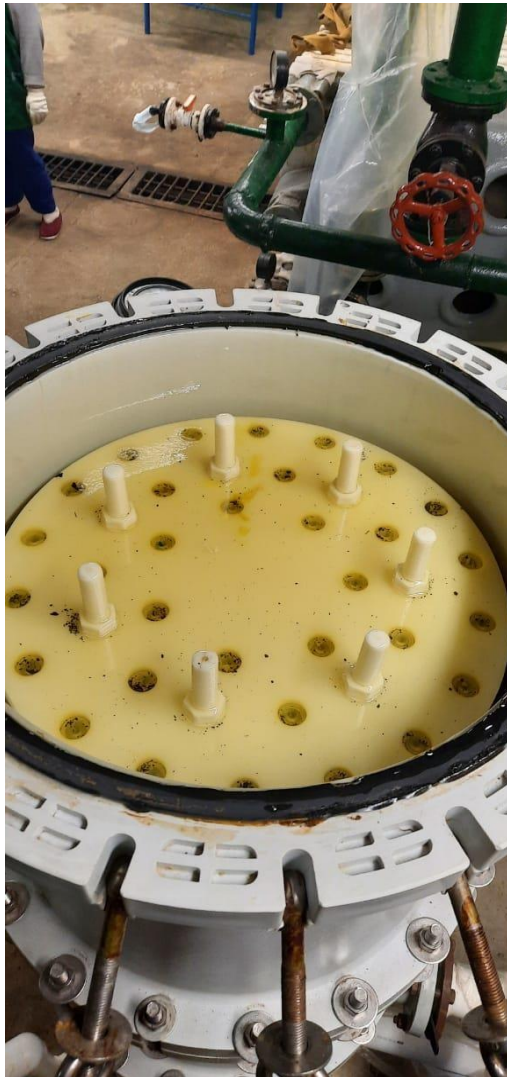
Рис. 46 – фильтр-элементы фильтра поз. Ф40 1 .
